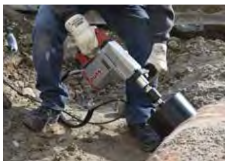
Navrtávání trubky z umělé hmoty – za sucha, s ručním vedením
