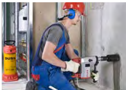
Vrtání otvorů pro elektroinstalaci do betonu – za mokra, s ručním vedením
