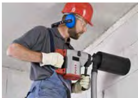
Vrtání do zdiva za sucha s odsáváním prachu, s ručním vedením
