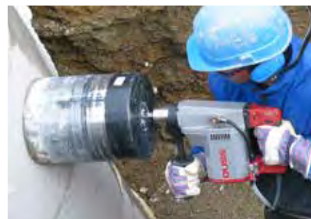
Navrtávání betonové šachty – za mokra, s ručním vedením
