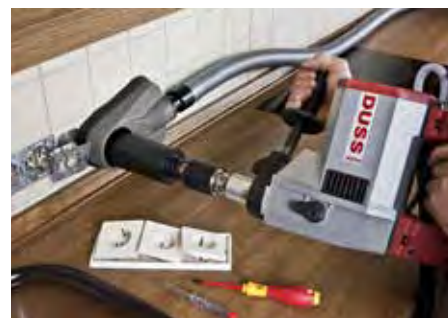
Čisté vrtání za mokra do betonu s odsávacím nástavcem DUSS, s ručním vedením
