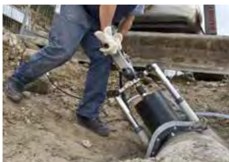
Navrtávání betonové trubky – za mokra, s vedením pomocí stativu
