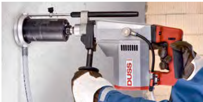
Vrtání otvorů pro elektroinstalaci do betonu s odsáváním vody
