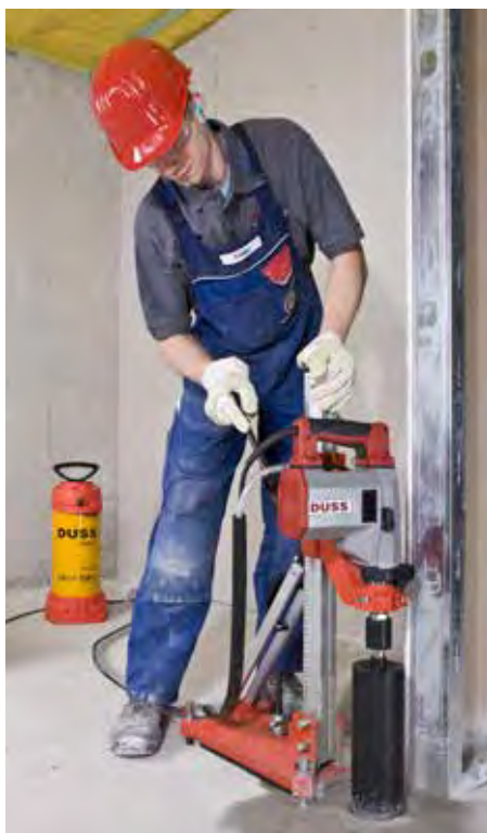
Vrtání za mokra do betonu, s vedením pomocí stojanu
